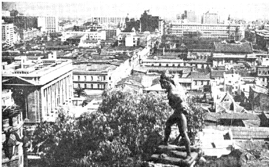
Caupolicán y vista desde el Cerro Santa Lucía.
