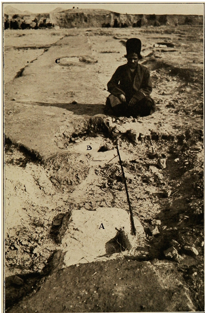
Fig. 16. — Fondations de porte. (Découverte du 2 février 1913.)
