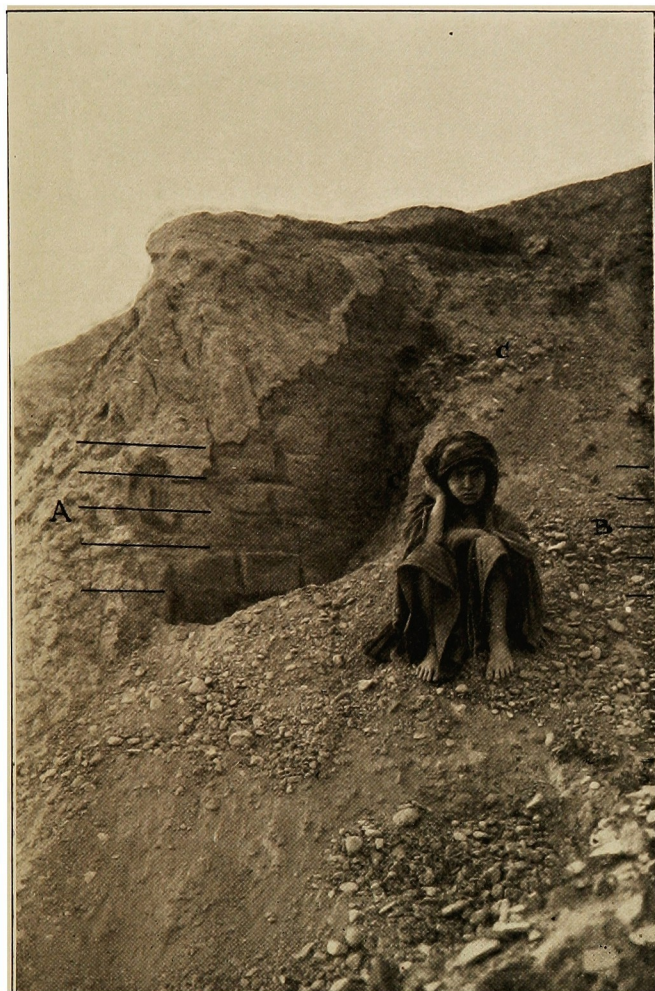
Fig. 28. — Exemple de mur d'enceinte en terre crue avec charge de graviers.
