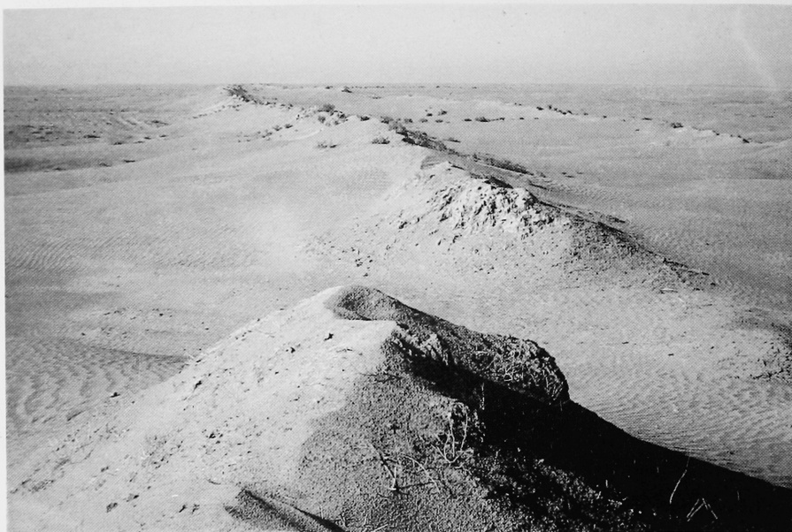
Pl. III. Le canal dit « de Oueili », abandonné et ensablé quelques années seulement après son aménagement.
