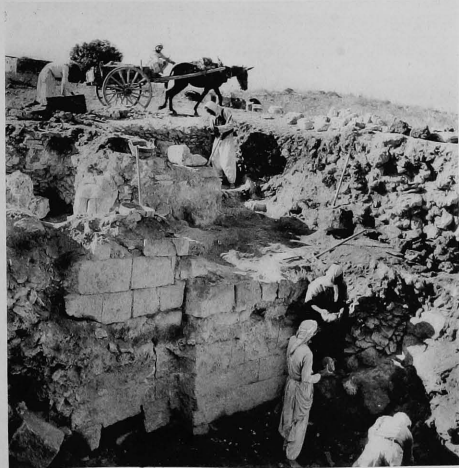
2. - Mur Nord des Archives internationales en cours de dégagement.
