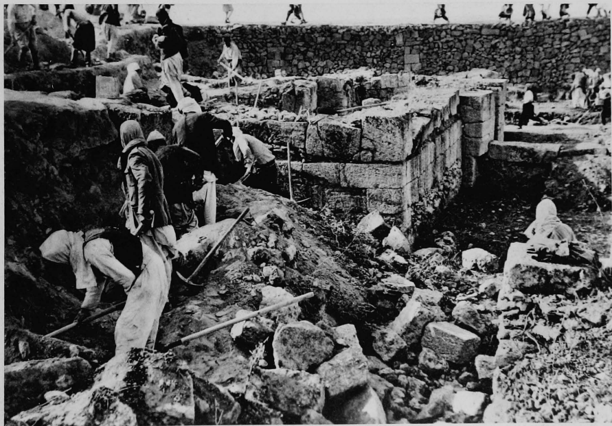
2. - Dégagement de la façade nord du palais d'Ugarit.
