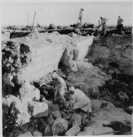
3. - Dégagement de la cour IV au Nord des archives internationales.
