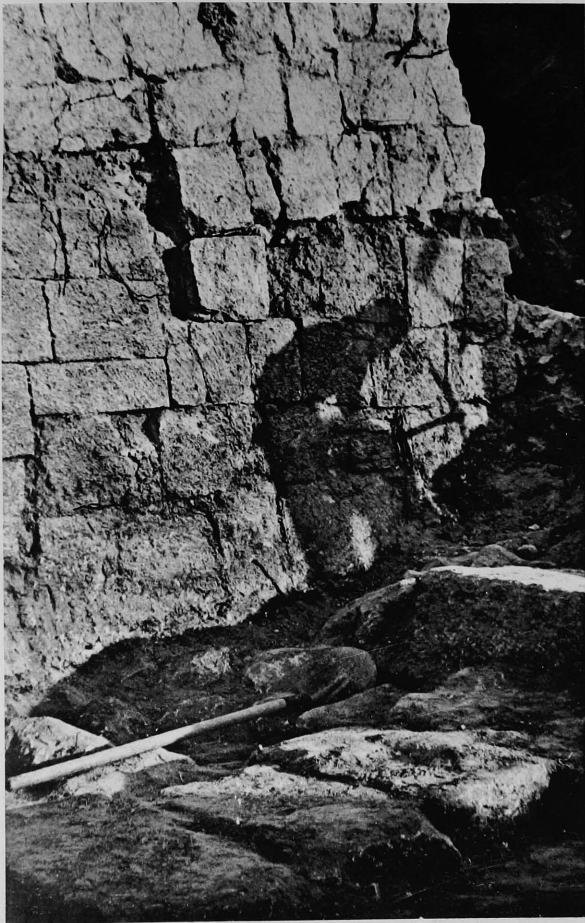
1. - Pan de mur incendié de la forteresse avec l'ombre de l'ouvrier qui dégage les dalles de couverture de la grande tombe I (1949).
