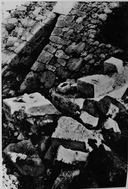
4. - Murs d'un ouvrage construit par-dessus le remblai de l'ancien fossé au pied du glacis.
