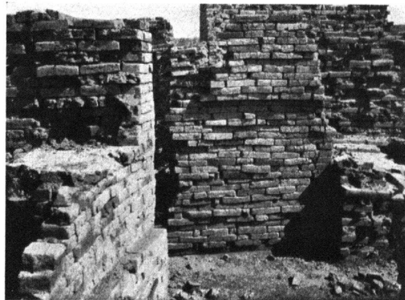
Abb. 14. Südende der östlichen Verbindungsmauer am Schenkel, von Westen her. Links die Südwand des Hakens, mit welchem die Verbindungsmauer an das Tor anschließt. Rechts das Gemäuer des Nordostschenkels.
