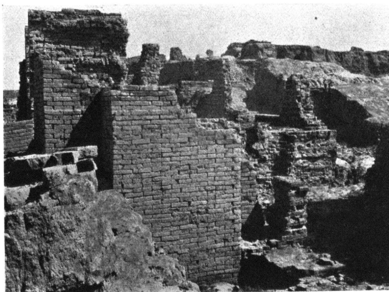
Abb. 45. Die Dilatationsfuge im Südwestschenkel von Westen her. Links der Vorsprung des ersten Turmes in der Schenkelmauer.
