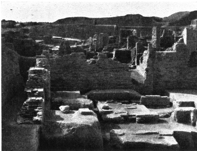
Abb. 42. Die Ostfront der Toranlage. Links Imgurbel mit einem stark vortretenden Lehmziegelturm, auf welchem späteres, ergänzendes Mauerwerk steht. Ganz oben links der Block mit der Torinschrift.
