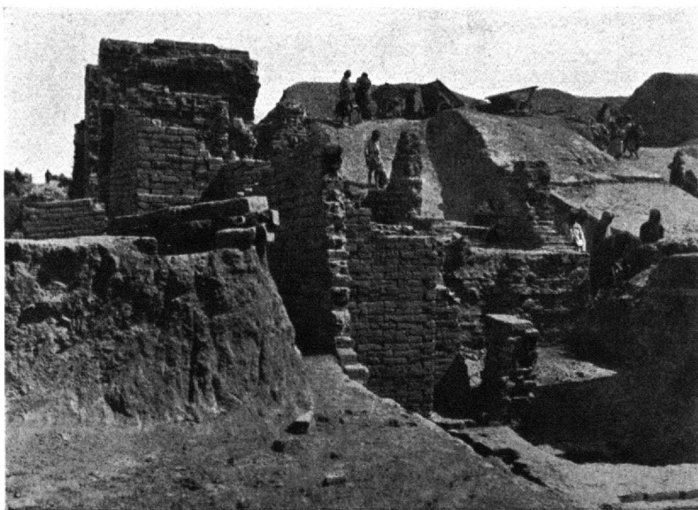
Abb. 47. Der südliche Westschenkel mit der Dilationsfuge. Links oben Wasserabflußkanal vor der Nordfront des Schenkels.
