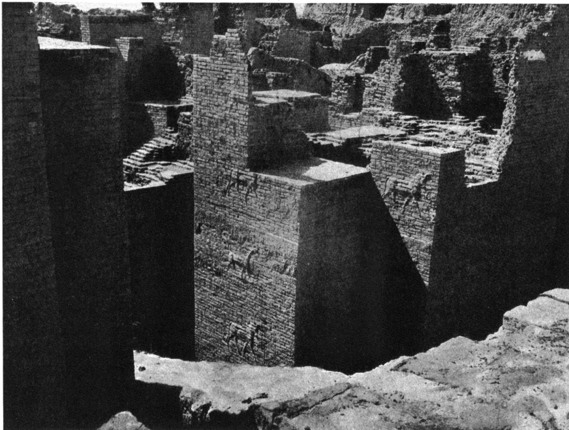
Abb. 18. Front des Nordtores vom älteren Pflaster aus, das rechts vorn sichtbar ist.
