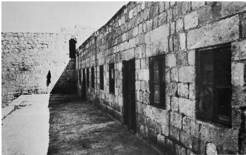
L'étage de la grande qaysariyya (aile sud) et la terrasse de distribution. Au fond, l'orifice d'un capteur d'air de bāding (salle de prière de la mosquée).
