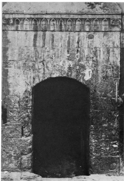
Porte d'entrée de la qaysariyya ouest.
