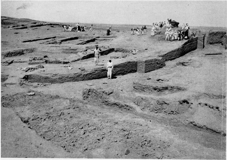
Fig. 405. — Enceinte extérieure, angle sud-est.
