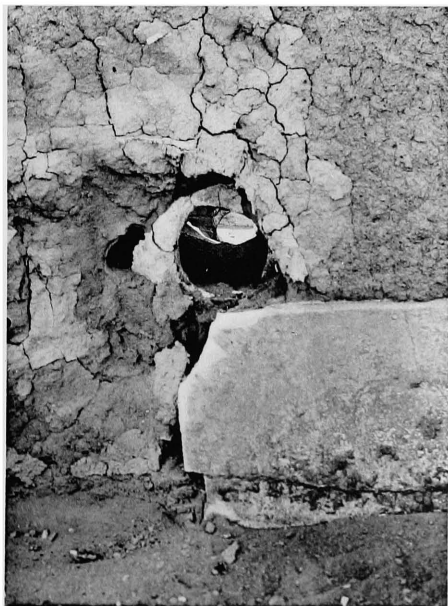
2. Débouché (cour 106) du bassin de la salle 107.
