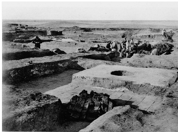
4. Salle 150, au podium . Dans le passage, porte calcinée, effondrée.
