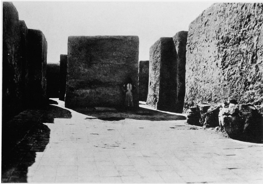
2. Cour 1, vue du bas, vers l'Ouest.
