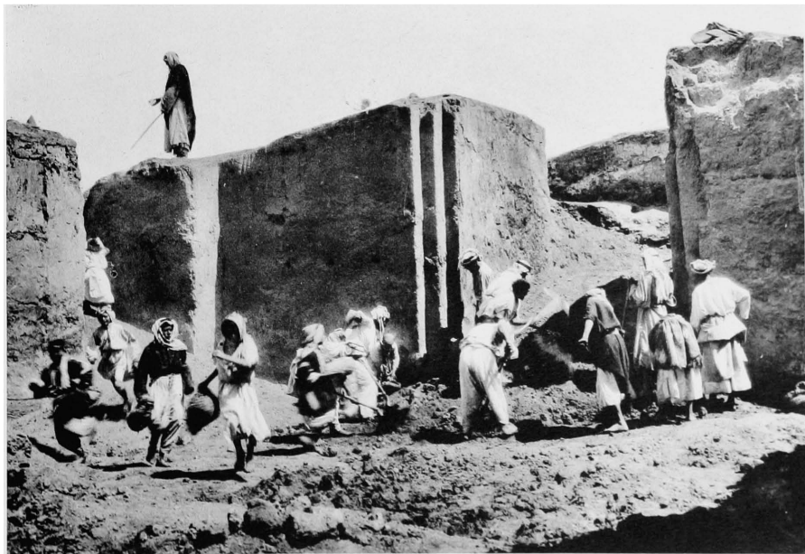
2. La salle du trône en cours de dégagement.
