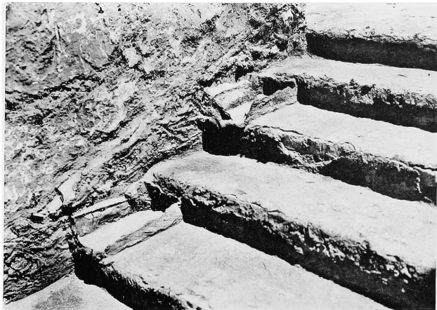
2. Marches de l'escalier de la tribune 66. Coffrets in situ .
