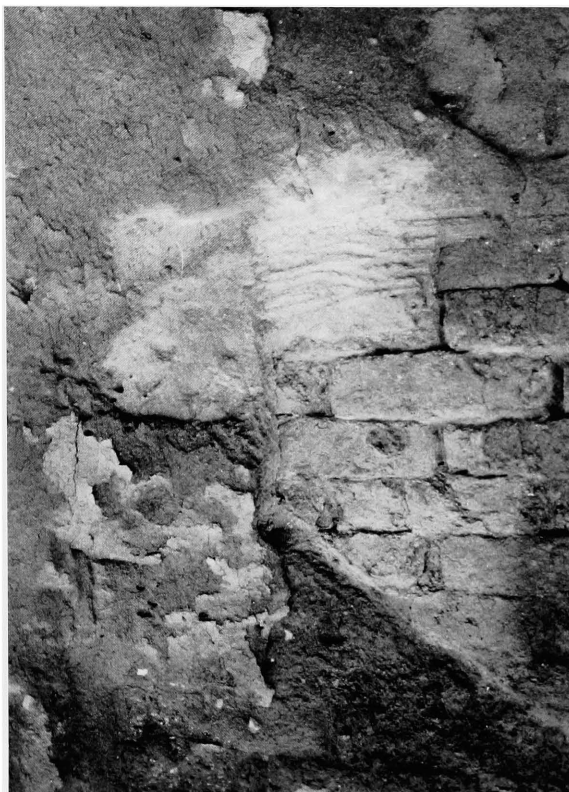
Fig. 109. - Salle 64. Détail du gros œuvre.
