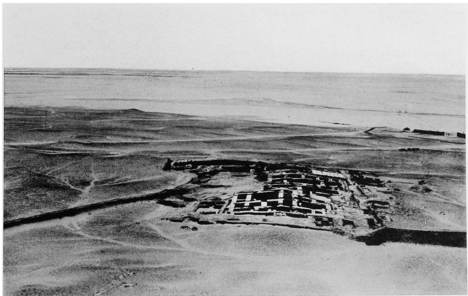
2. Vue vers l'Ouest. État du dégagement en avril 1935.
