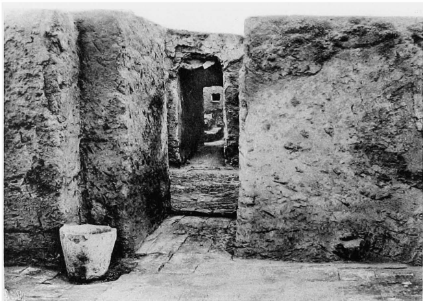
1. Vers la salle de bains 7, par les pièces 14 et 12.
