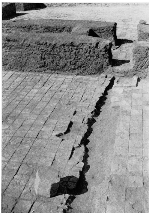
Fig. 17. — Cour 160 vue vers l'Ouest. A l'arrière-plan, avant-cour 154.
