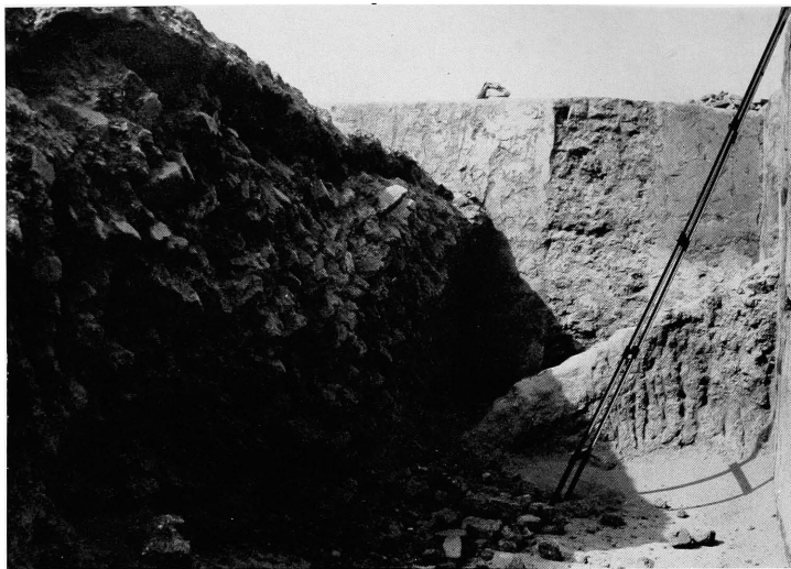
Fig. 114. -- Salle du trône 65. Éboulis in situ . A l'arrière-plan, porte 65-62 comblée par les éboulis.
