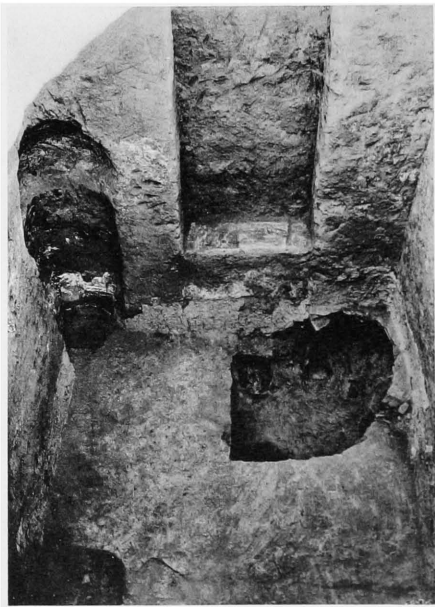
4. Salle 69. Emplacement de baignoire et placard, paroi est.
