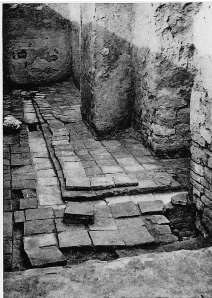
2. Salles 81 et 82 avec canalisation sous le dallage.
