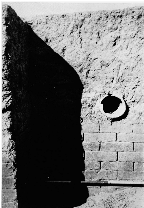
Fig. 378. — Débouché de canalisation. Enceinte orientale.
