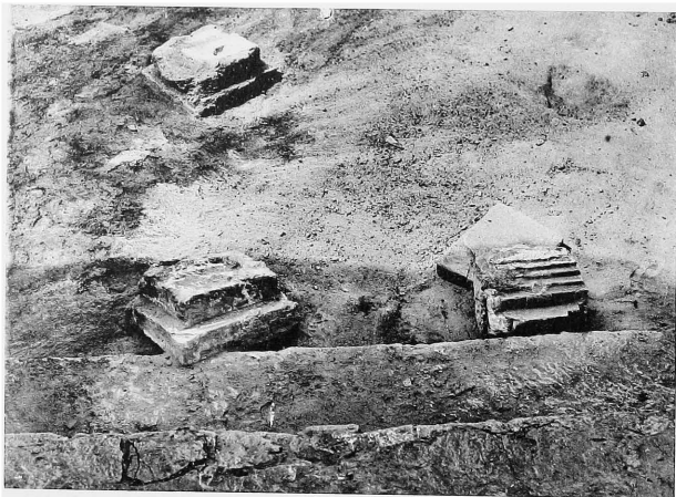
1. Socles de statues au pied de l'escalier de la tribune.
