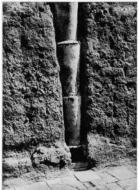
4. Appel d'air dans le mur du couloir.
