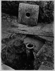
Abb. 5. Gelochte Platte über Tonrohr für den "Baldachin".
