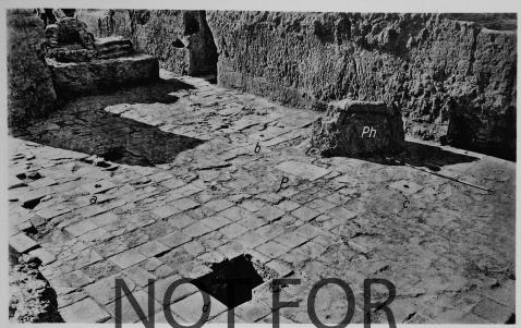
Pflaster im Kultraum der Aschuritu a, b, c, d: Lochstein mit Tonrohr darunter — P: Gipssteinplatte — Ph: Tonphallus
