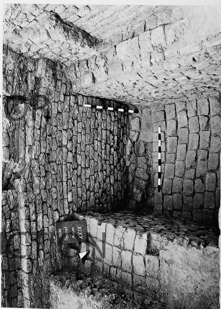
1c Blick in den Schacht von NO
