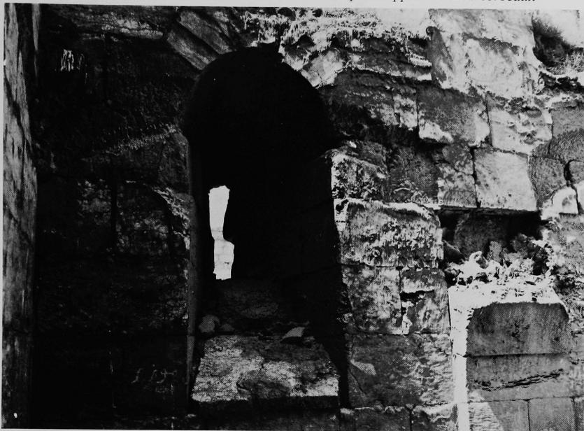
a) Un pilastre portant un arc diaphragme remplaçait dès le premier état la poutre médiane existant dans d'autres bastions
