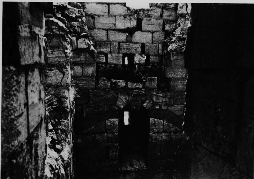
b) Reprise en brique au-dessus d'une clef de voûte affaissée, engravure de la voûte.
