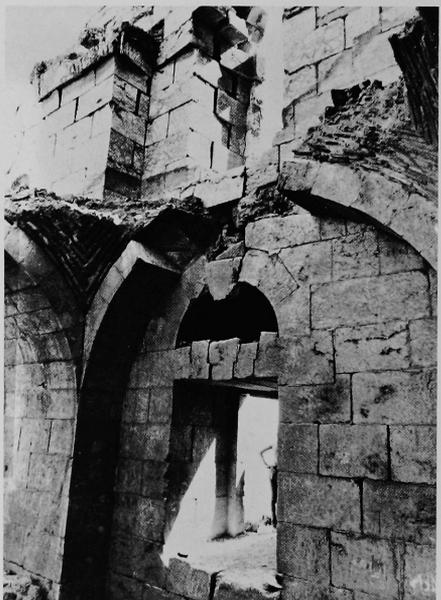
d) Porte du 1<sup>er</sup> étage (linteau appareillé et reins des voûtes d'arête) (cl. JL)
