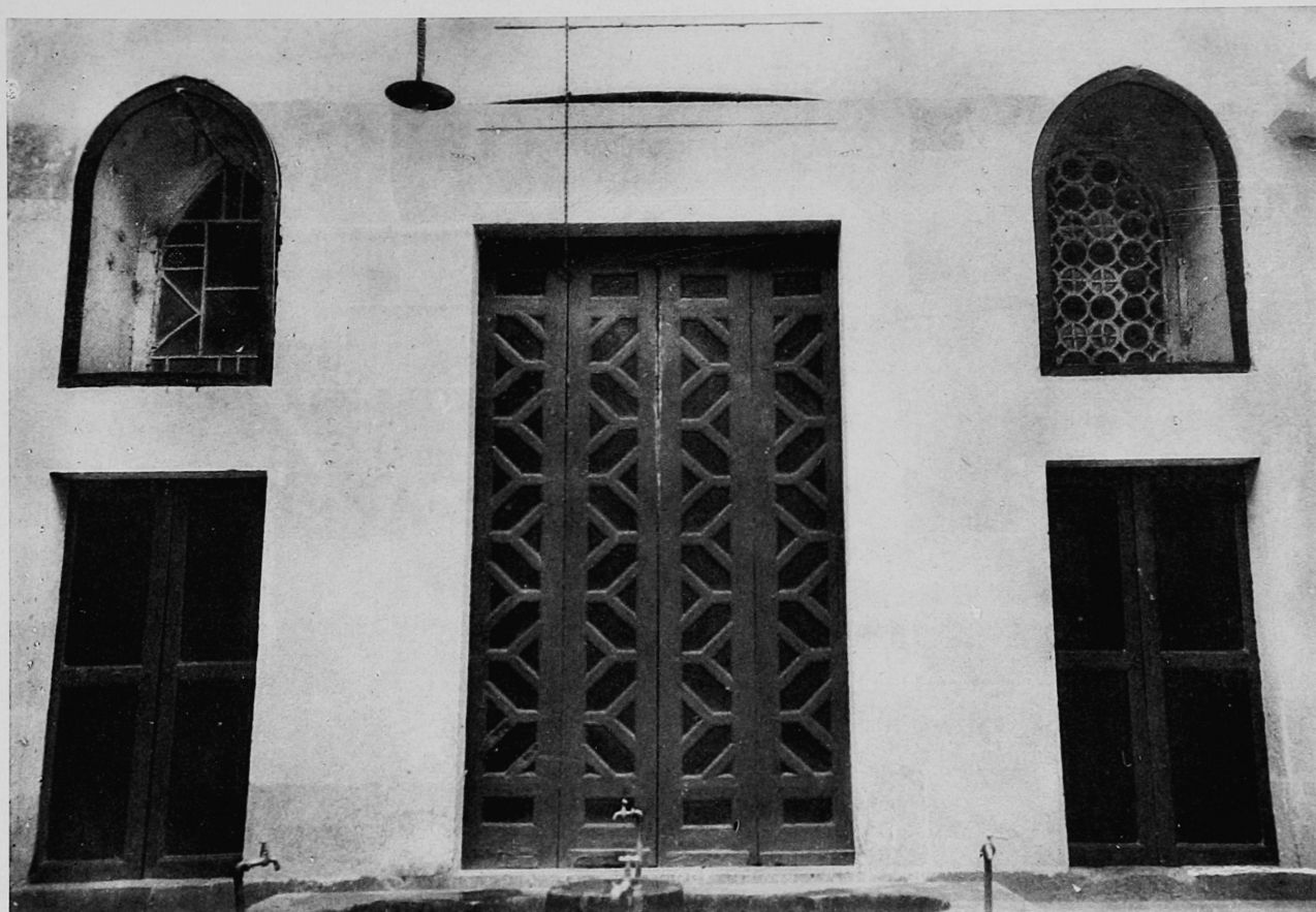
1. - Façade de la salle de prière.
