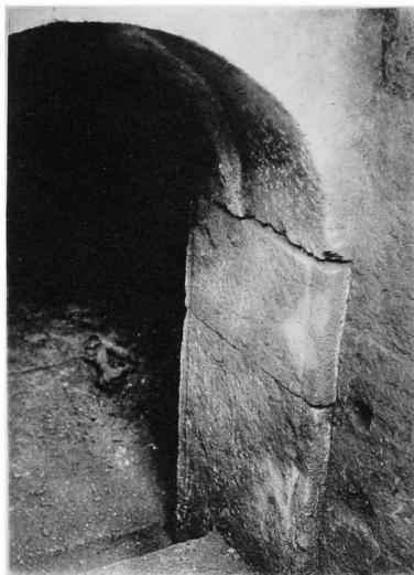
2. Piédroit avec feuillure et logement d'une horizontale de fermeture de porte. Tombe III, Minet-el-Beida.
