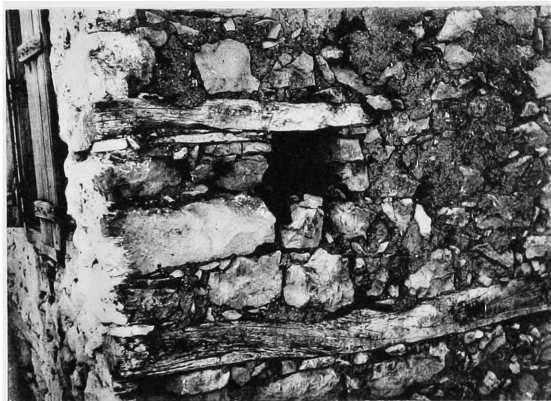
4. Maison actuelle de Kessab (sur la pente du Djebel Akra) avec mur en pierre sèche armé de poutrage.
