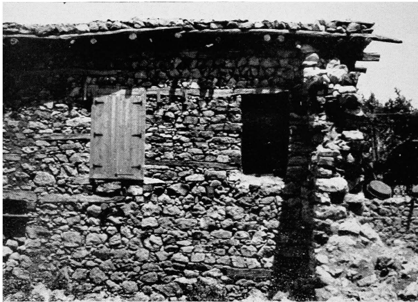
Fig. 90. — Chainage de poutres dans les murs en pierre sèche du village de Kessab, versant S du Djebel Akra (p. 96).
