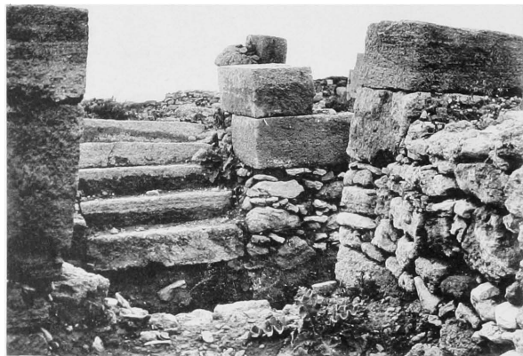
3. Escalier montant au premier étage.
