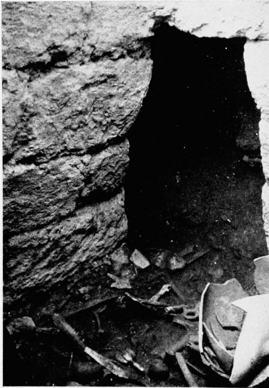
Fig. 61. — Porte de communication entre les caveaux LVI et LVII (p. 67).
