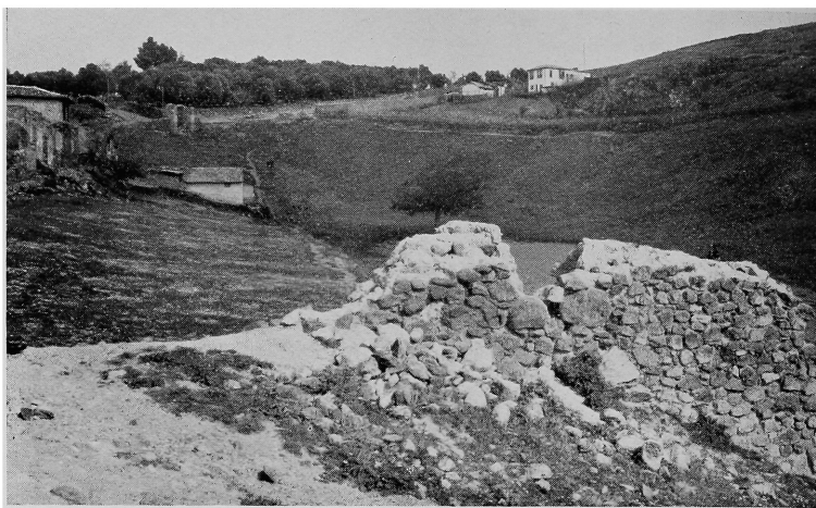
SITE OF THE STADION
