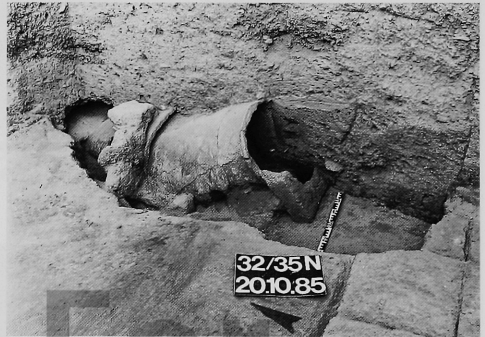
4. Anlage B 14, Abwasserleitung
