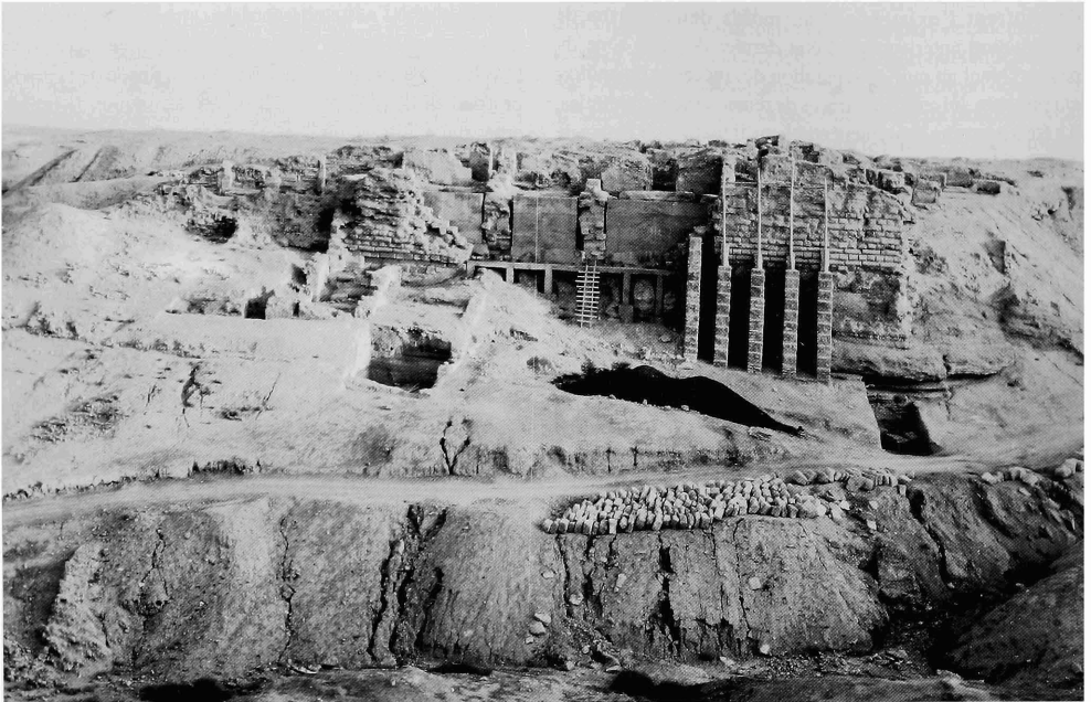
Fig. 8 - Achèvement de la construction des voiles de béton et de la plateforme destinée à recevoir la nouvelle façade. La masse de matériaux est de la pouzolane employée pour combler les espaces entre les remblais du palais et les voiles de béton. Vue vers le sud.
