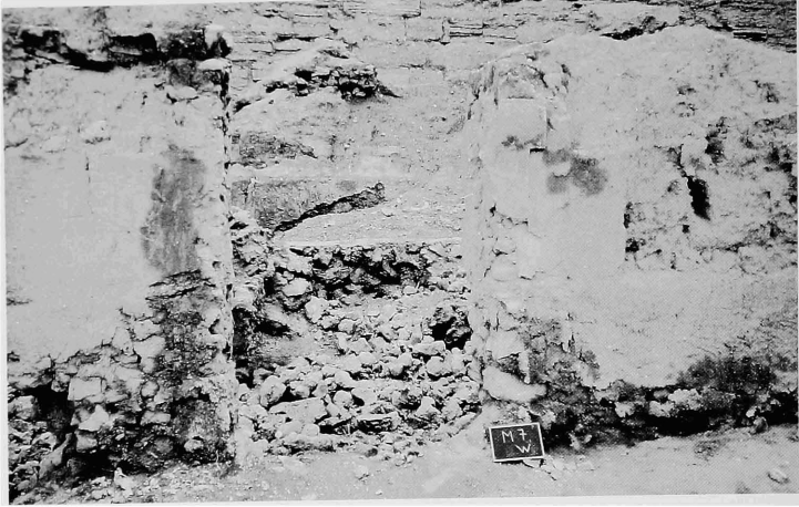
Fig. 13 - Remontée de l'humidité dans les murs (M7W).
