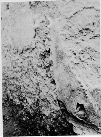
Fig. 7 - Salle 10 : feuillure destinée à recevoir un panneau de fermeture sur le côté est du passage le long du mur séparant les salles 9 et 10.
