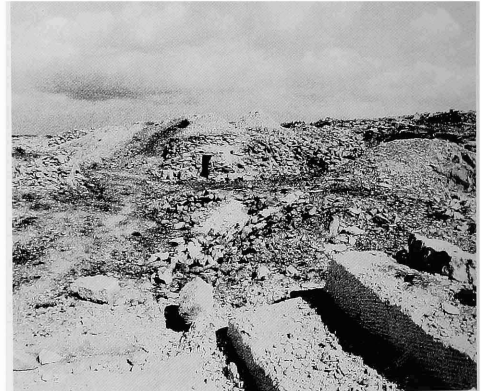
Fig. 4 - Groupe de cabanes (qubab) de pierre sèche incluses dans les déblais de carrière, qui servent d'abris aux carriers et constituent probablement la jonction de plusieurs propriétés.
