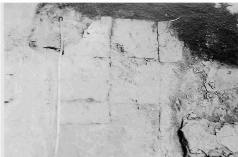
Fig. 12 - Réfection en briques du pavement dans l'angle sud-est de la salle 10, devant le banc 542.
