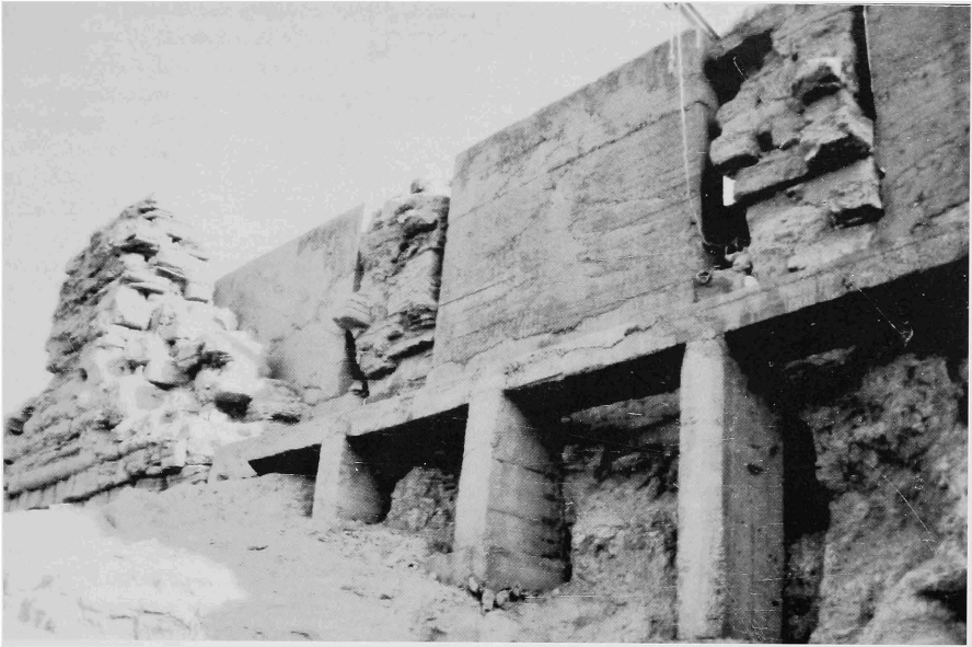
Fig. 7 - Palais du Stratège. La façade nord après la mise en place de la plateforme et des voiles de béton. La plateforme repose sur des piliers ancrés dans le rocher. Vue du pied du palais vers le sud-est
