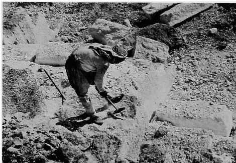
Fig. 12 - Traçage d'un bord de tranchée à l'aide d'un pic d'extraction.
