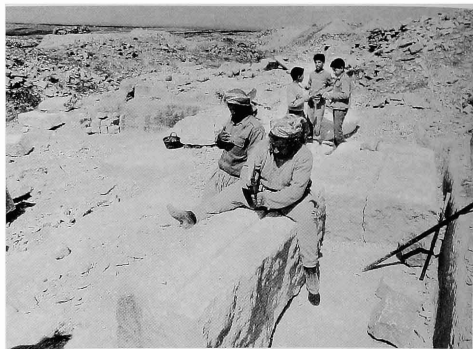
Fig. 21 - Préparation du débit en deux parties d'un gros bloc fracturé puis isolé du front de taille visible à l'arrière plan. Le carrier assis sur le bloc termine par petits coups de mortaisoir le fond de l'encoignure verticale.
