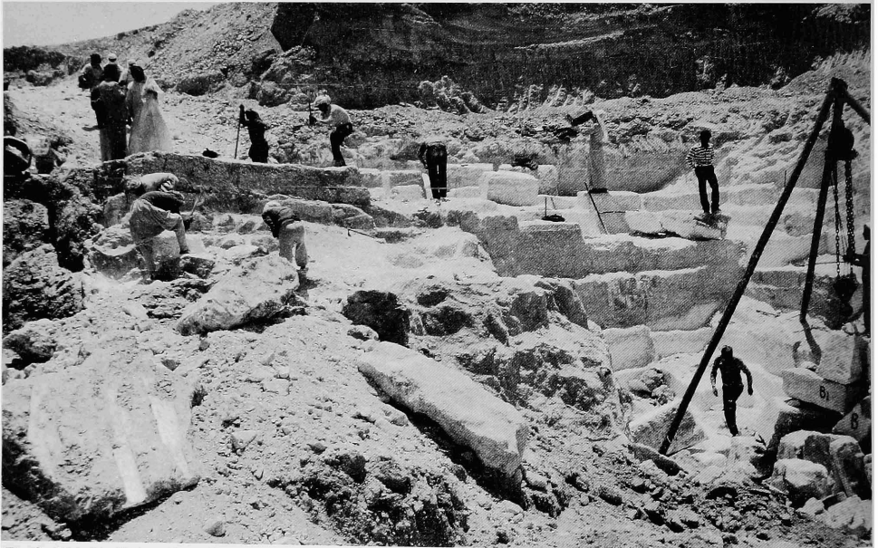
Fig. 9 - Chantier d'extraction collectif dans la carrière de Résaфа, consacré à la production de blocs de gypse pour le palais présidentiel (photo prise en 1986).
