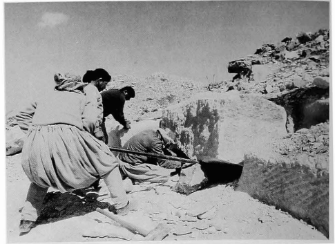
Fig. 24 - Dégagement d'un bloc de son emplacement naturel en le soulevant à la pince de carrier. L'ouvrier accroupi place des pierres dans l'axe longitudinal, en-dessous de la face inférieure du bloc, de façon à ce que celui-ci soit en bascule lorsque le carrier cessera de forcer.
