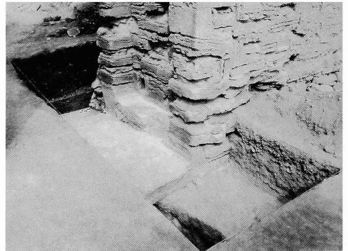
Fig. 6 - Sondage sur la porte secondaire : dégagement de la fondation du jambage nord et mise en évidence des restes du bouchage et de la sape passant sous celui-ci. Vue vers le nord-ouest.
