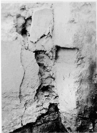
Fig. 8 - Système de fermeture sur le côté ouest du passage le long du mur séparant les salles 9 et 10.
