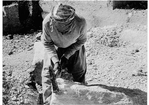
Fig. 23 - Régularisation de l'arête d'un bloc brut d'extraction en utilisant la dabbârâ du côté de sa tête à quatre arêtes, en adoptant la position de travail spécifiquement orientale, c'est-à-dire perpendiculaire au parement.
