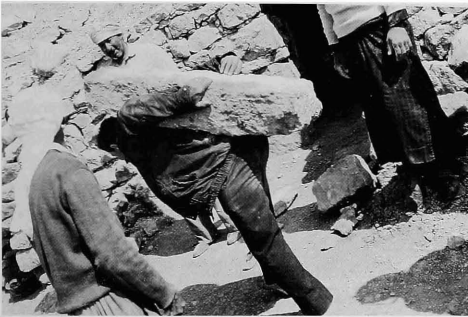
Fig. 26 - Démonstration de portage d'un bloc à dos d'homme selon la méthode traditionnelle. Anciennement, les carriers possédaient pour cela un vêtement spécial qui facilitait l'opération et le maintien du bloc sur le dos. La pierre portée ici pèse environ une centaine de kilos.
