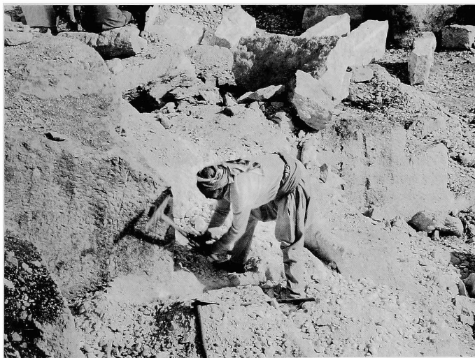
Fig. 15 - Carrier en début du creusement d'une tranchée d'extraction.
