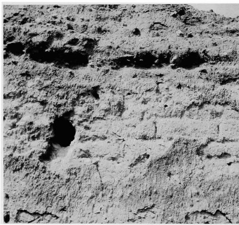
Fig. 5 - Brique crue liée au mortier d'argile et partiellement recouverte d'un enduit de djousse.
