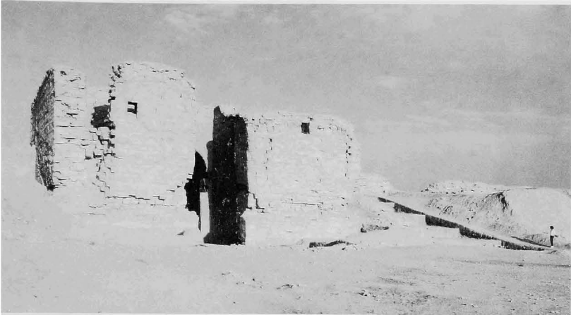
Fig. 20 - Porte de Palmyre, extérieur ouest. Vue générale à la fin de la campagne 1993. Vue vers l'est.
