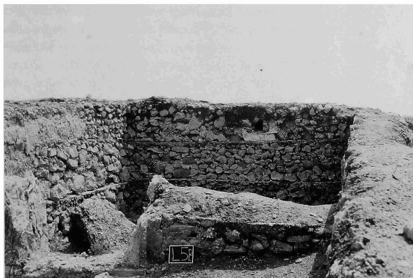
Fig. 2 - Le blocage «en arases» (L5B). La disparition des enduits laisse voir la juxtaposition des arases. Noter la niche au fond de la pièce.
