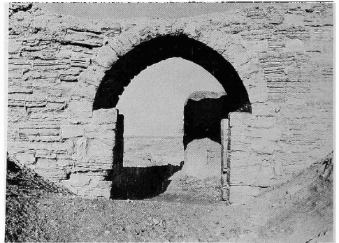
Fig. 3 - Porte secondaire. Vue de l'extérieur de la ville avant les travaux. Noter, à l'arrière, l'angle de l'îlot de la maison chrétienne qui empiète sur le passage. Vue vers l'est.
