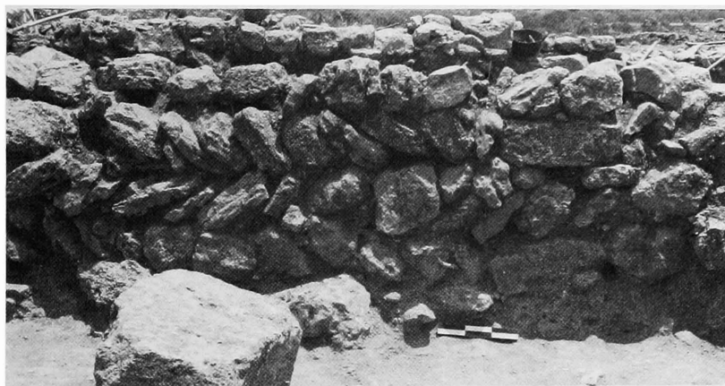
c. Trennmauer zwischen Raum 8 und 9 von Haus I in « Fischgrät-Technik », Blick von Westen.
