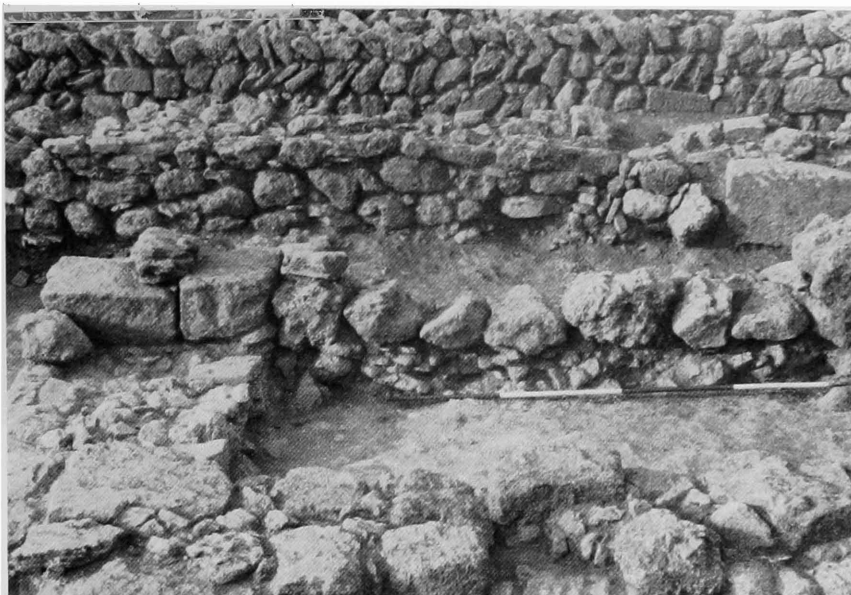
a. Mauerzüge in U-V/14-15 von Osten.
