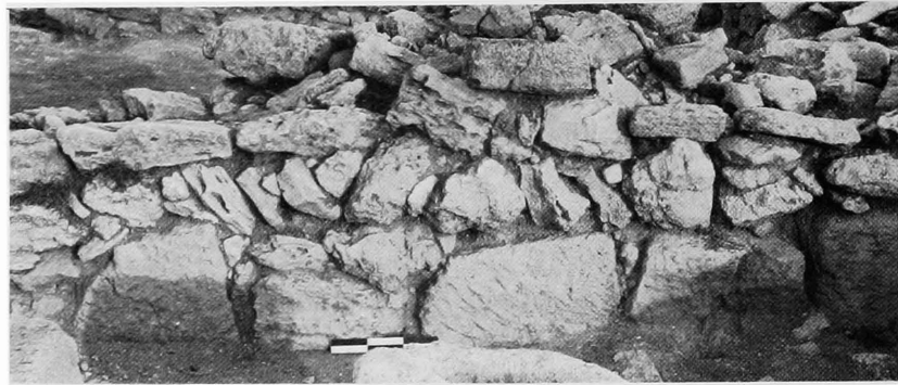
b. Haus I, erneuerte Trennmauer zwischen den Räumen 2 und 3.
