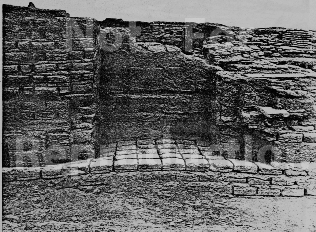
b) Türanlage und Überführung der Tür in eine Nische. Südostwand des Ningizzidtempels.
