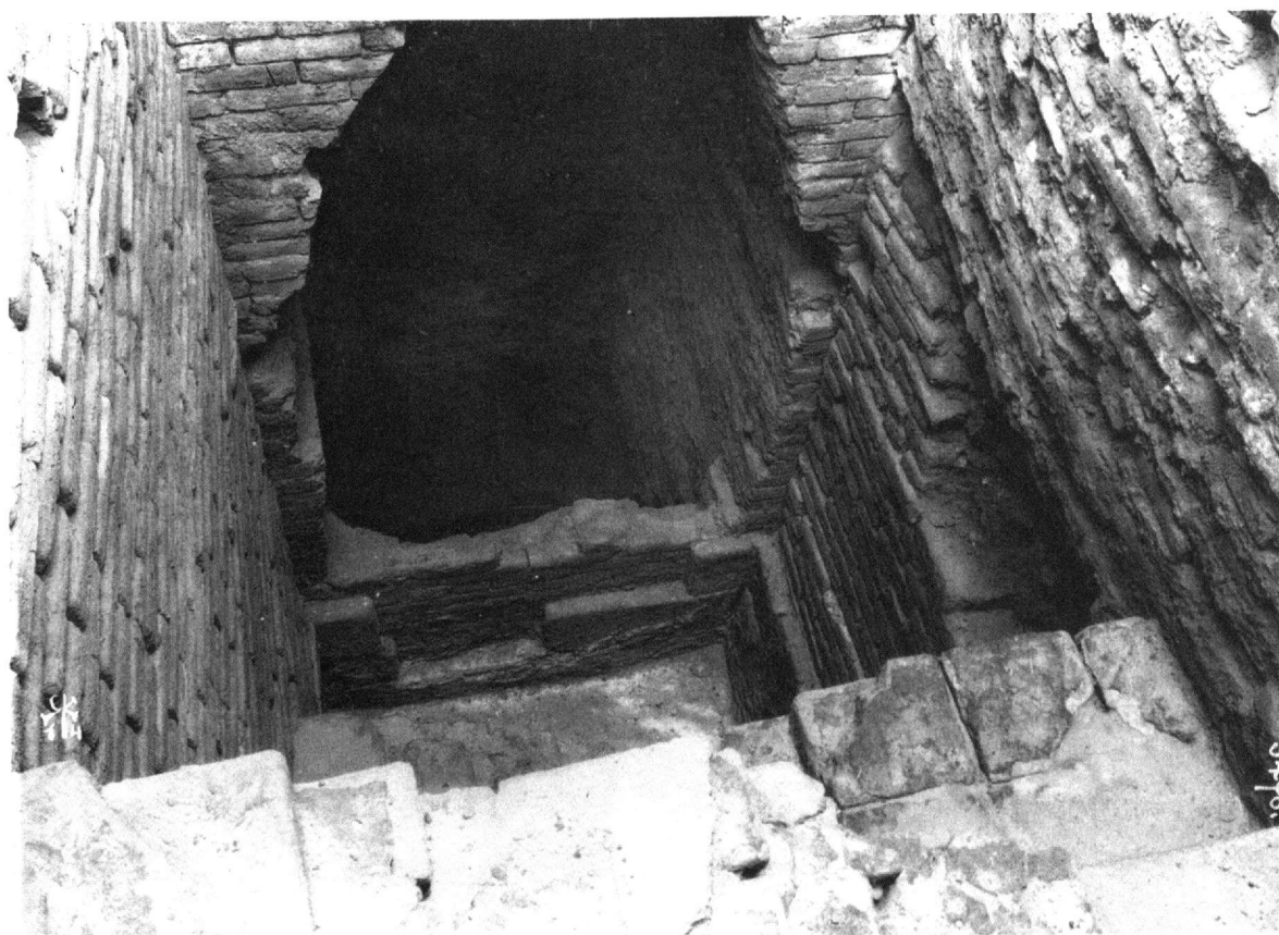
SCHACHTÖFFNUNG VON WESTEN
