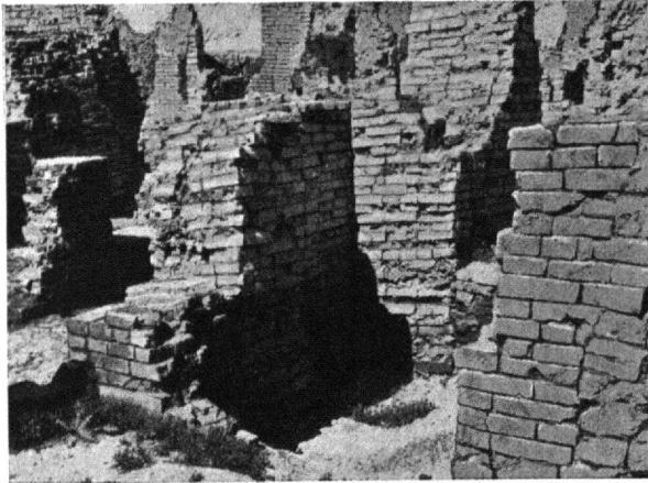
Abb. 49. Dilatationsfuge im Nordwestschenkel von Südosten her. Die Wand rechts gehört dem Torgebäude an.
