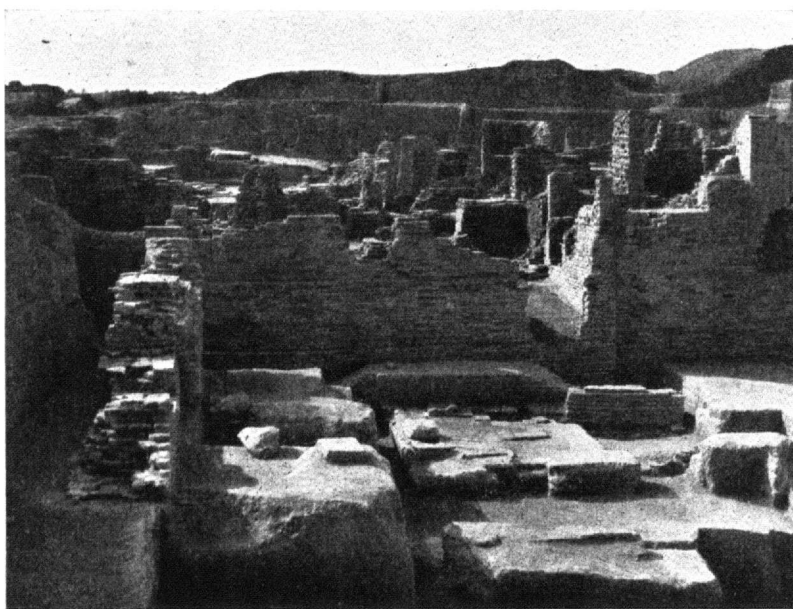
Abb. 42. Die Ostfront der Toranlage. Links Imgurbel mit einem stark vortretenden Lehmziegelturm, auf welchem späteres, ergänzendes Mauerwerk steht. Ganz oben links der Block mit der Torinschrift.
