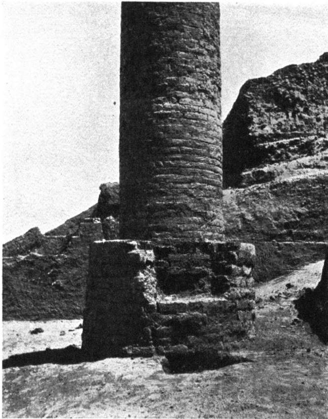
Abb. 10. Das runde Postament auf dem Vorplatz. Es steckt in der brunnenförmigen Fundament-Ummauerung aus Lehmziegeln, die zum Teil ausgebrochen ist, sodaß das untere Ende des Postamentes sichtbar wird.
