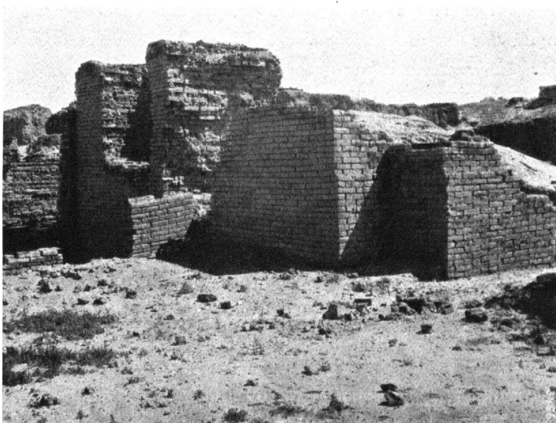
Abb. 48. Der Südwestschenkel von Nordwesten. Die Mauerfläche rechts gehört der Dilatationsfuge an, die etwas schief stehende Mauer vor dem Schenkel gehört zu der Zwischenmauerung zwischen den beiden Schenkeln.
