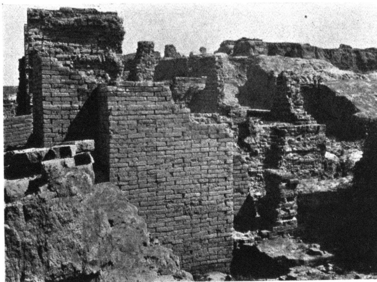
Abb. 45. Die Dilatationsfuge im Südwestschenkel von Westen her. Links der Vorsprung des ersten Turmes in der Schenkelmauer.
