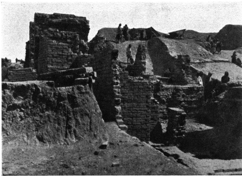
Abb. 47. Der südliche Westschenkel mit der Dilationsfuge. Links oben Wasserabflußkanal vor der Nordfront des Schenkels.
