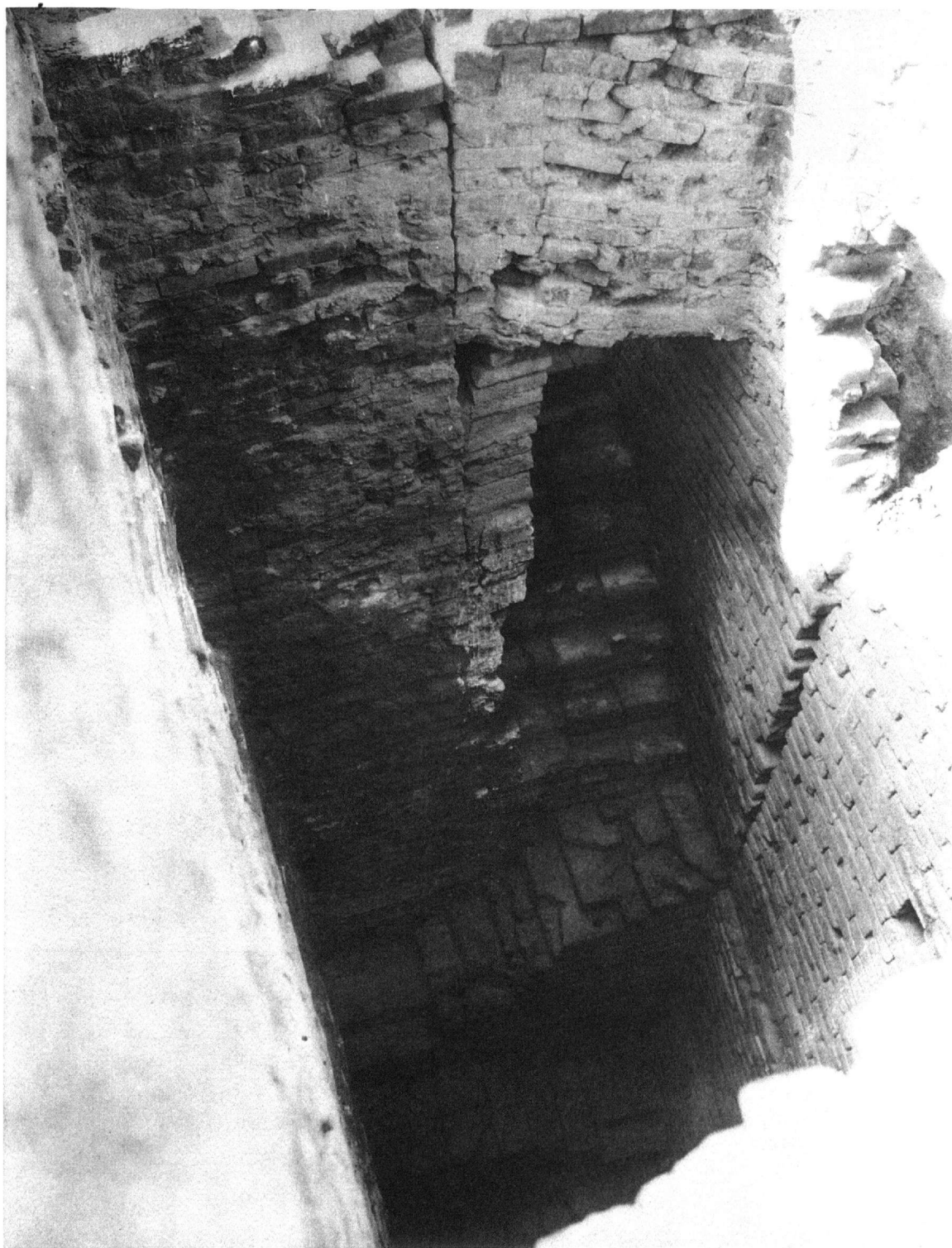
DER BRUNNENSCHACHT AM NORDWESTSCHENKEL VON OBEN
